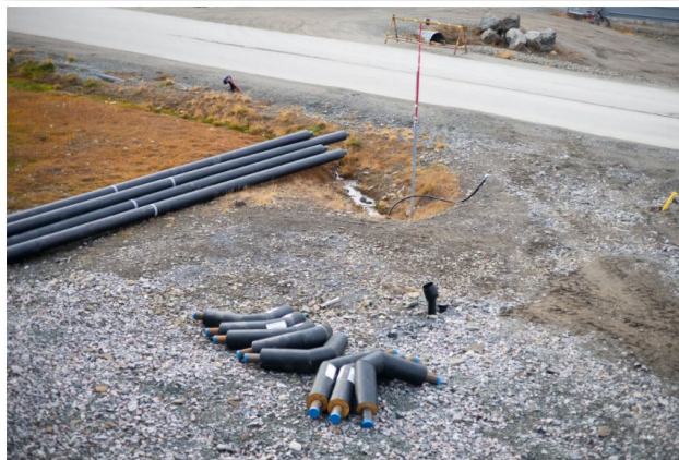
En uke på overtid melder Svalbard Energi at de nærmer seg ferdig med å bytte ut fjernvarmerør som går til Vel 228 og Vel 230. Foto: Anna Stjern
