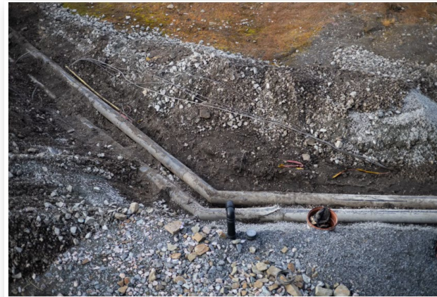
LNS Spitsbergen, Rambøll og Svalbard Energi er i gang med å grave opp fjernvarmerør som går til Vel 228. Foto: Anna Stjern
