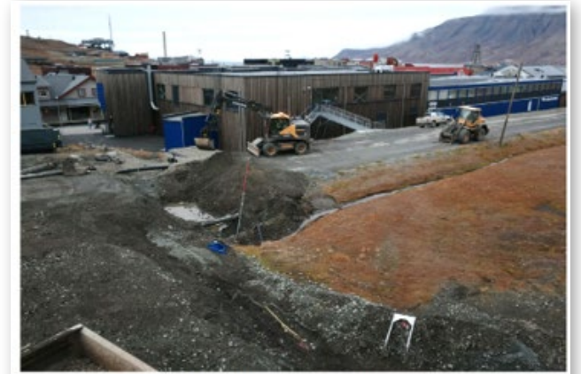
LNS Spitsbergen, Rambøll og Svalbard Energi er i gang med å bytte fjernvarmerør som går til Vel 228 og 230. Foto: Magnus Hansen
